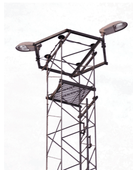
Nya lampor - Foto Bo Axhammar
